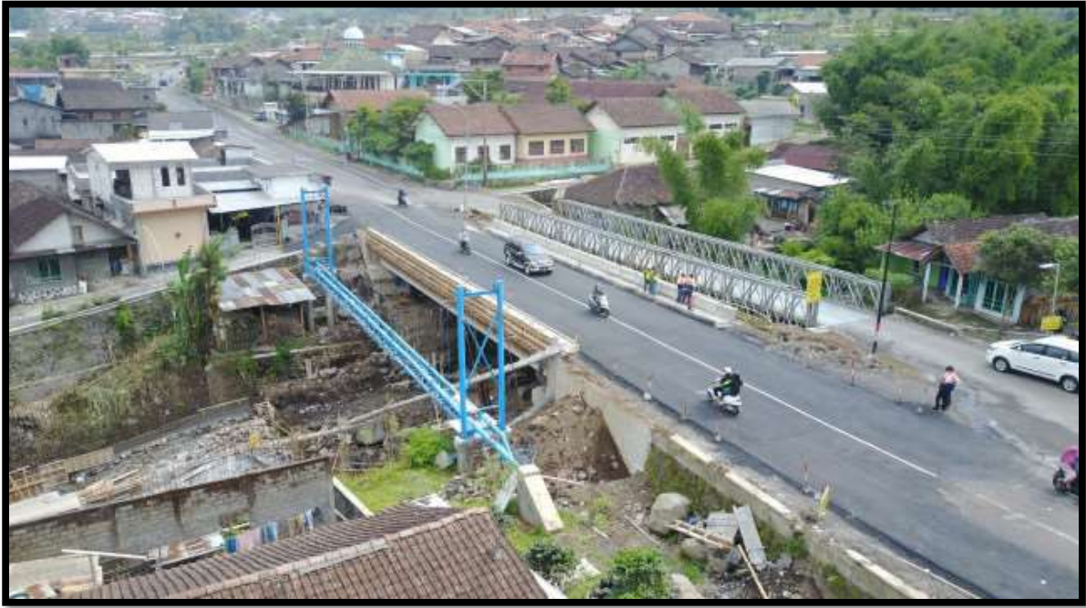
Pembangunan Jembatan Lodukuh Temanggung
