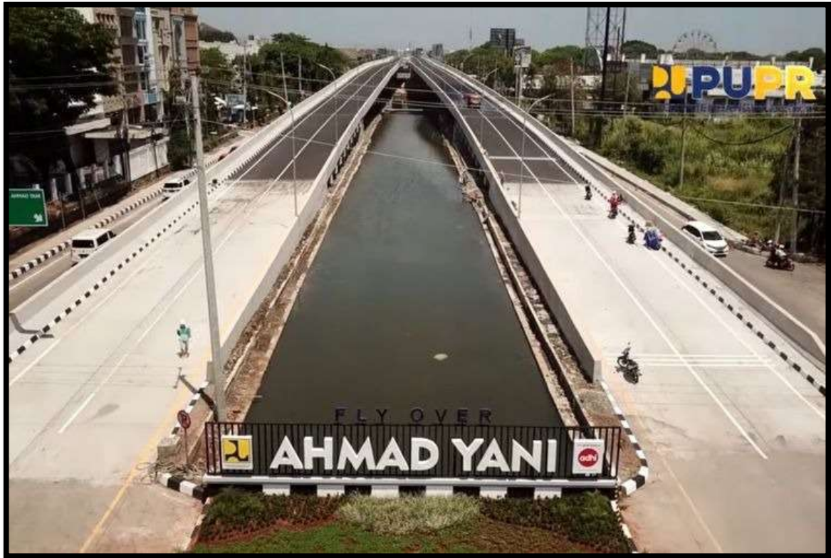
Pembangunan Fly Over Ahmad Yani Semarang
